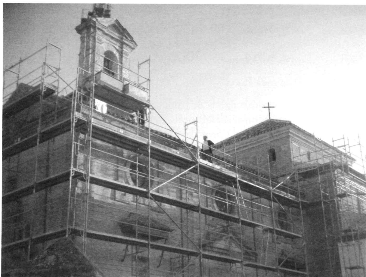
Obras en la Ermita. Verano 2013. Foto: M. Martínez
